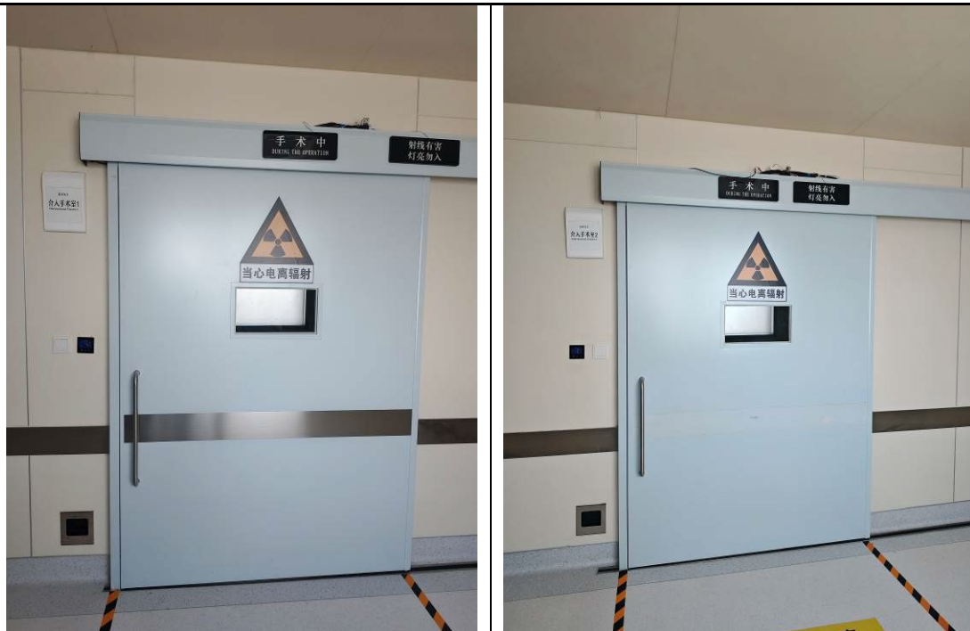
图 3-3 本项目防护门及警示标志
